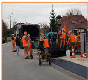
Le point sur les travaux
