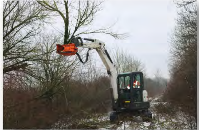
Travaux d'élagage par l'entreprise Koeren (janvier 2021).
