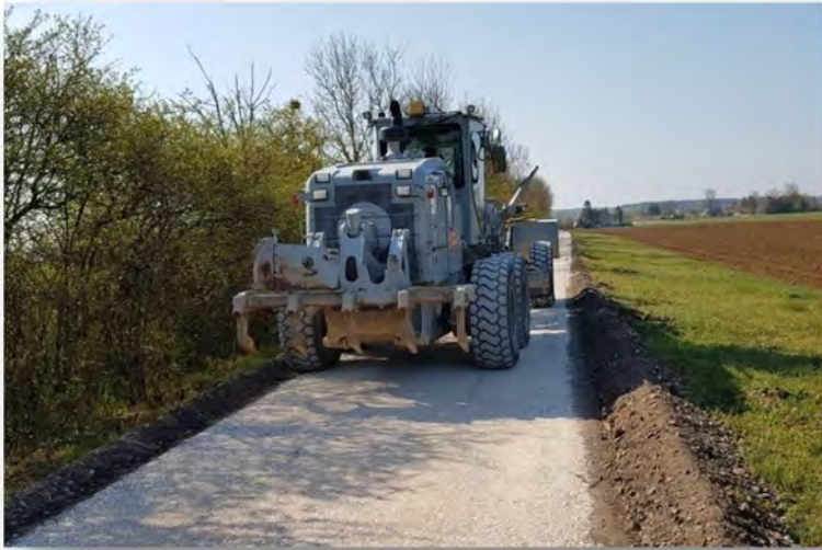
Passage de la niveleuse (avril 2021)
