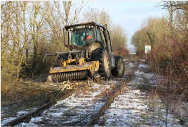
Premier passage du broyeur
