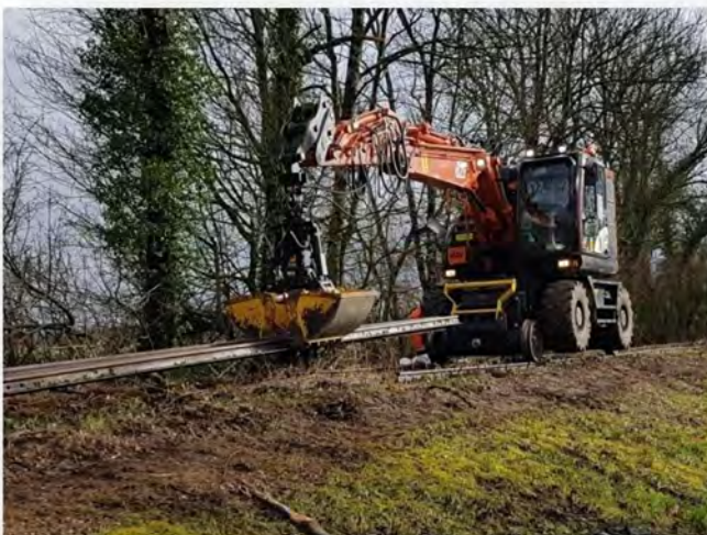
Dépose des rails
